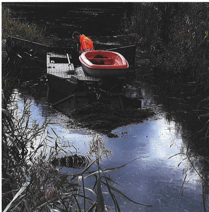
Met een duwboot werd de bagger naar de kant geduwd, waarna het werd opgezogen.
